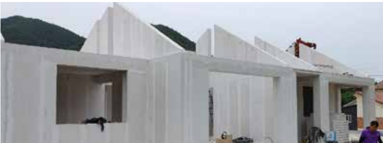
[사선패널 시공 사례]
