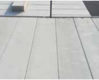
[바닥패널 시공 사례]
